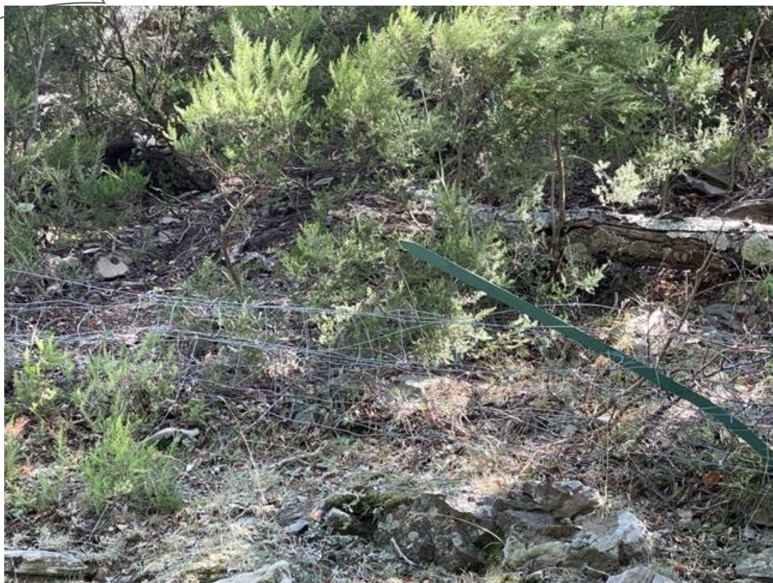
Photographie n° 3 : Exemples de dégradations de la clôture malgré un entretien pluriannuel.
